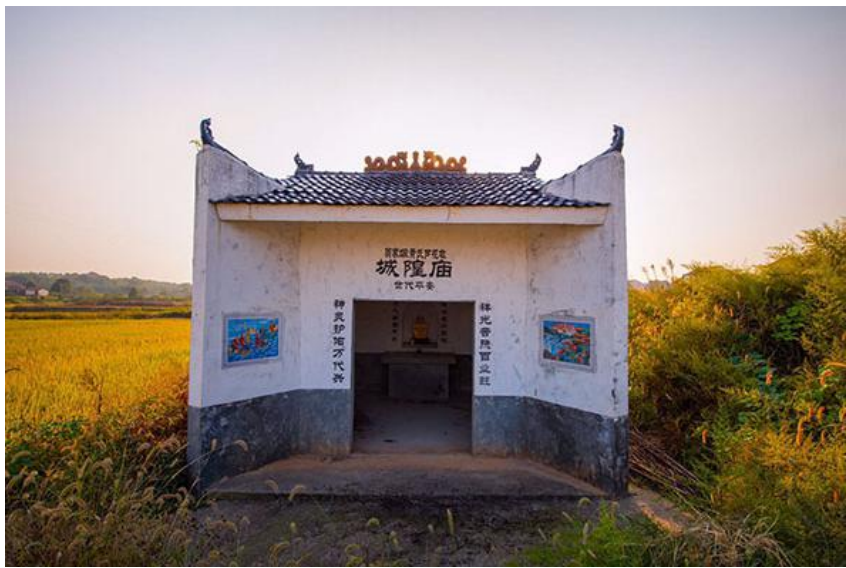
白塘镇穆屯村 翁家段黄氏芦 花墩城隍庙 (原古老建筑 大集体时改田 被毁)公元二 零一二年十月 重修(为首建 者:福新,建良)
