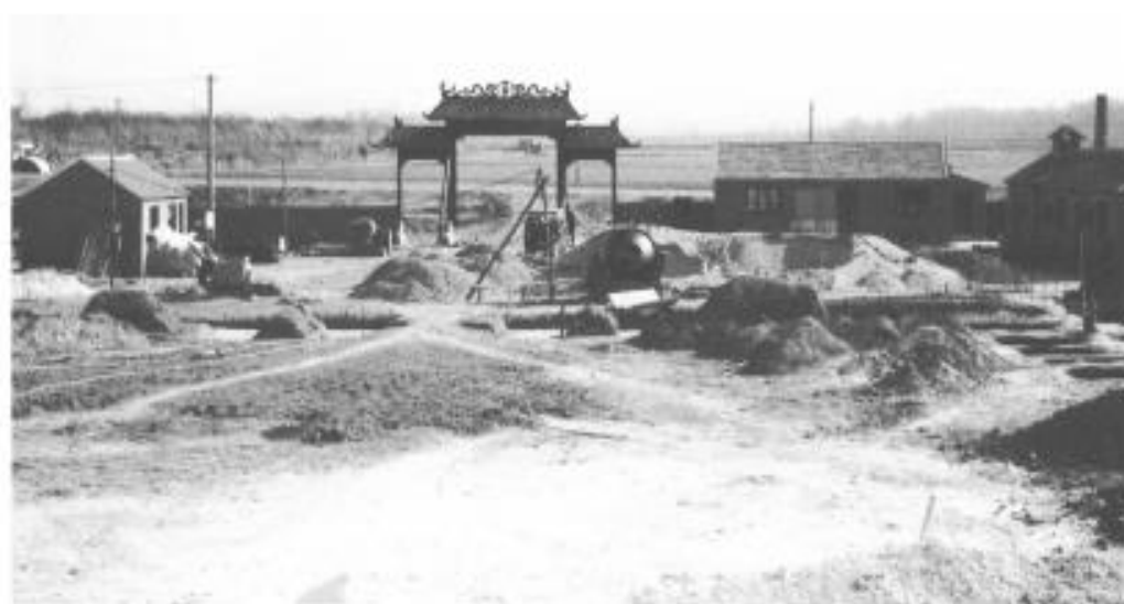
中华谭 氏大宗祠施 工现场。位 于章丘市龙 山镇谭国故 城遗址西侧。 门前为济青 公路，左侧 台地为古谭 城遗址。占 地两万多平 方米，仿周 代宗庙建筑。 由著名古建 筑设计师杨 洪勋教授设 计。
